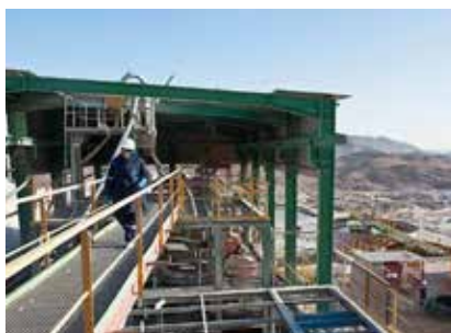
Extension de l'usine CTT-GUEMASSA
