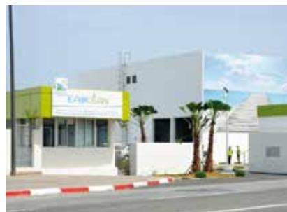
Station Eaucéan de prétraitement des eaux usées
