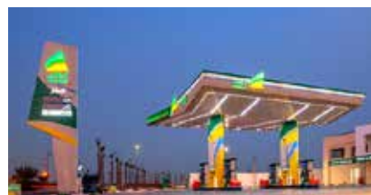
Station-service Atlas Sahara sud du Maroc
